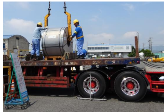
歯止めがなされているトレーラー
