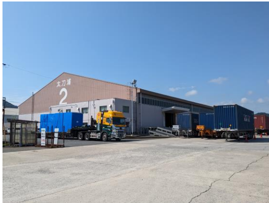
巡視場所全景
